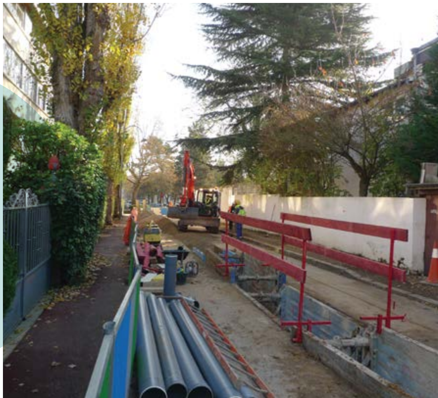
Travaux d'assainissement rue Achille-Garnon menés par Vallée Sud-Grand Paris.
