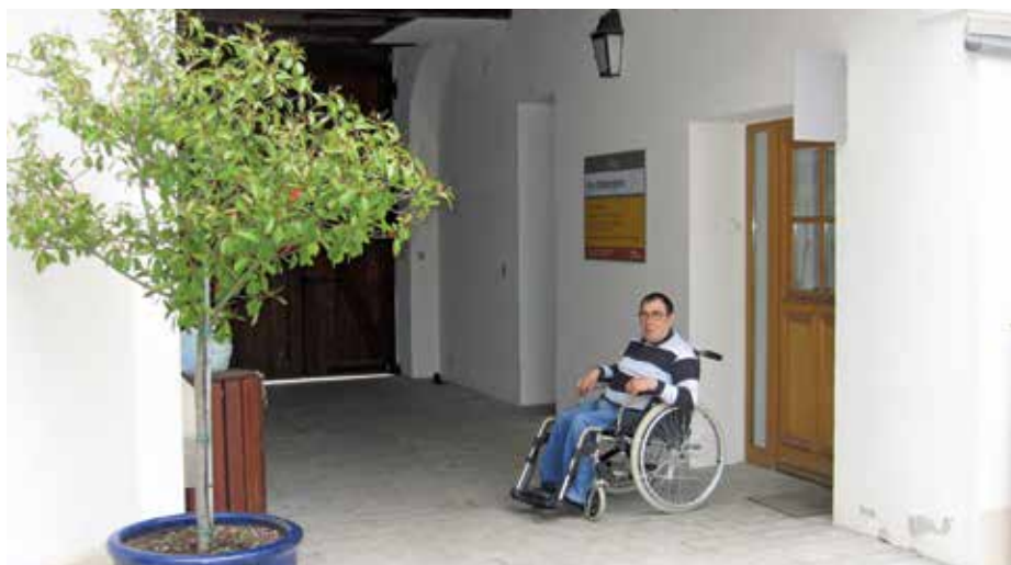
La mise en accessibilité de l'accueil du foyer-logement Les Imbergères (suppression des marches) était « indispensable », selon Claude Morin.
