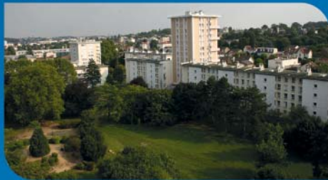
Résidence des Bas Coudrais. Travaux de rénovation en cours.
