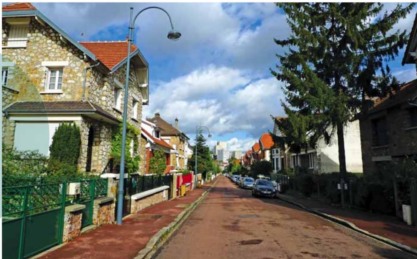
Rue Berlioz, l'enfouissement des réseaux a permis de valoriser l'aspect visuel et la qualité de l'environnement urbain.
