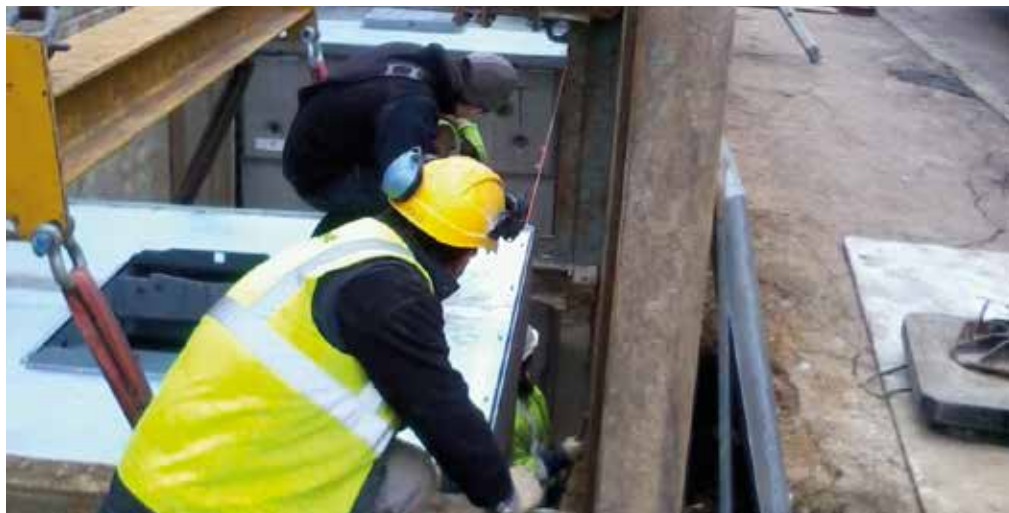
Pose des cuves dans le quartier des Bas-Coudrais, rue des Aulnes.
