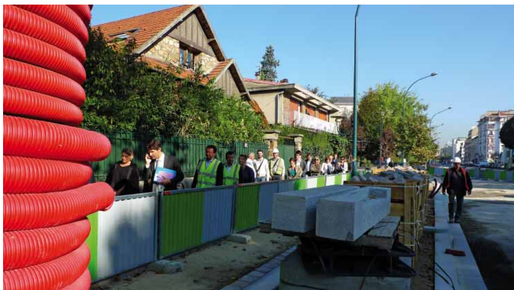
Visite de chantier à Sceaux sur la route départementale 920.
