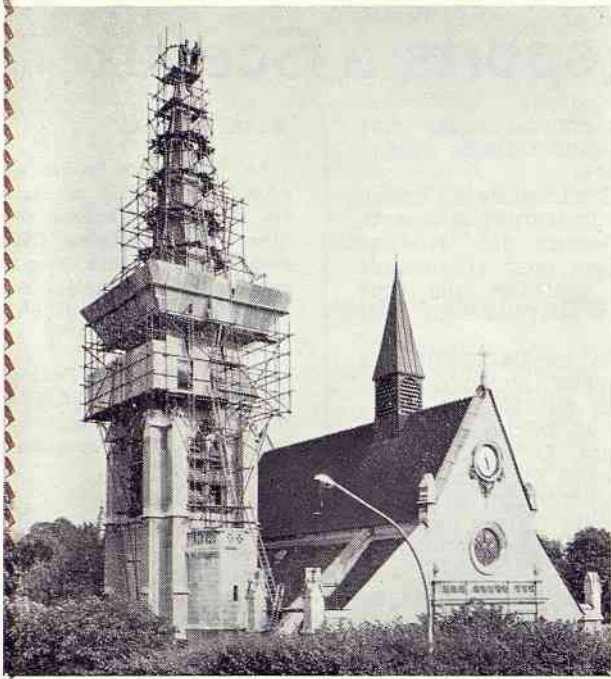
Le clocher de l'Eglise SAINT JEAN-BAPTISTE de SCEAUX avait été endommagé très sérieusement par une tornade.
