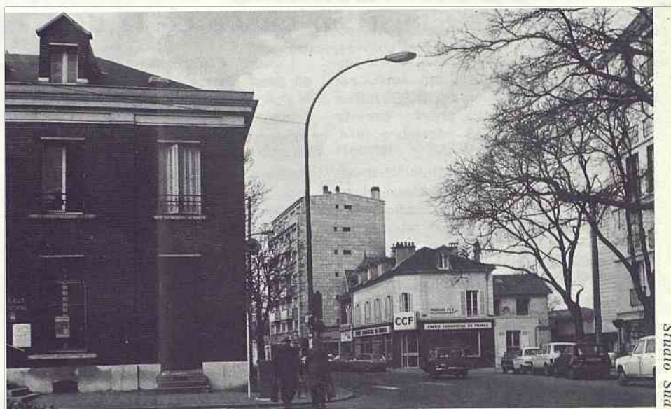
L'extension du Central téléphonique permettra de dégager ce goulot d'étranglement de la circulation, dont piétons, automobilistes et riverains souffrent également.
