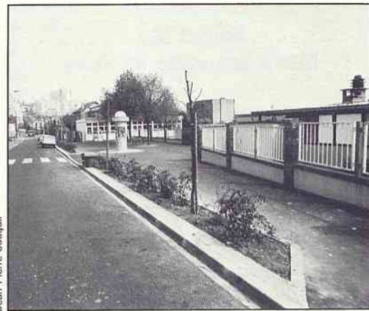
L'aménagement de l'entrée du groupe scolaire des Blagis, rue de Bagneux. Arbres et arbustes accompagnent l'opération de voirie
