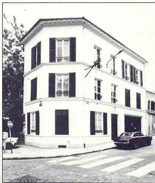
L'immeuble du 10, rue Florian après travaux
