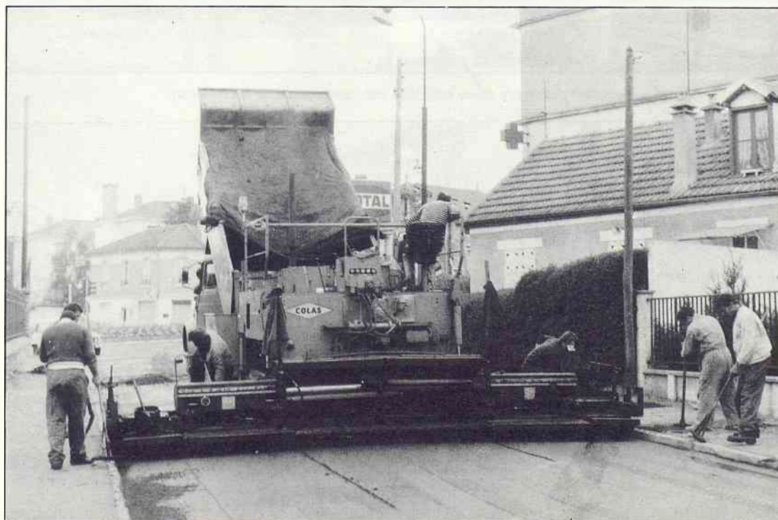
La pose d'un revêtement bitumineux, rue des Aulnes.
