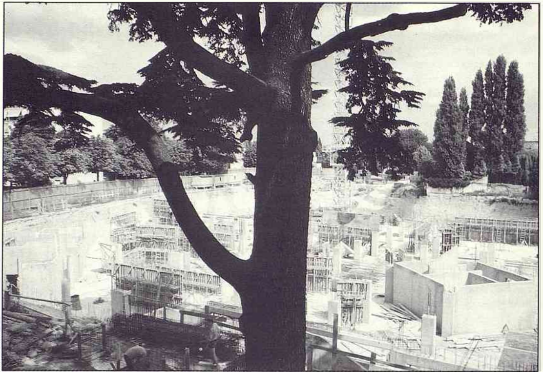
Le chantier depuis l'îlot 6 - Septembre 1983.
