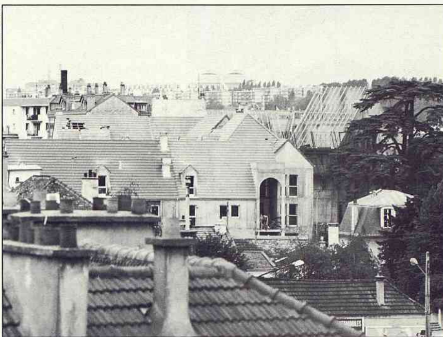
Charaire vu du haut de l'échafaudage de l'église - Octobre 1983.
