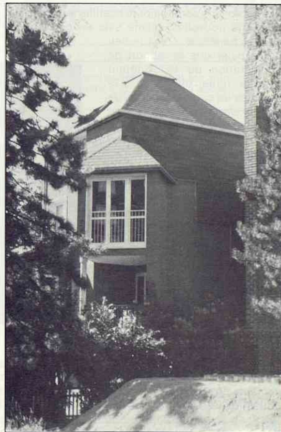
Allée Jean-Barral : extension d'un pavillon HLM.
