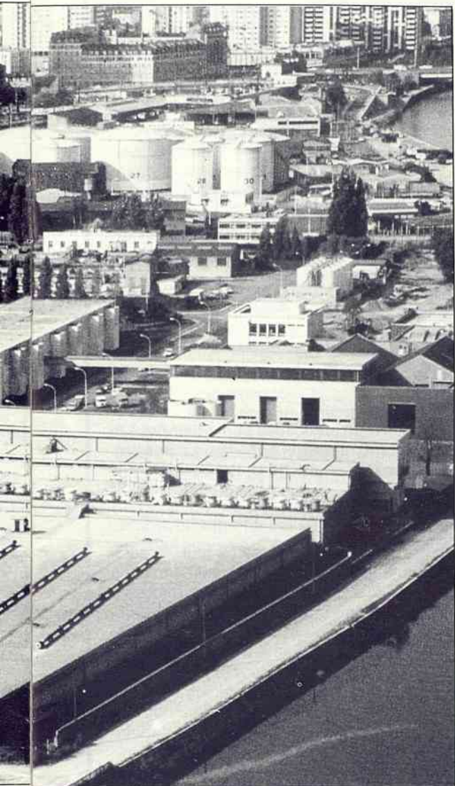
capacité de production : 800 000 m 3 par jour. à partir de cette usine.
