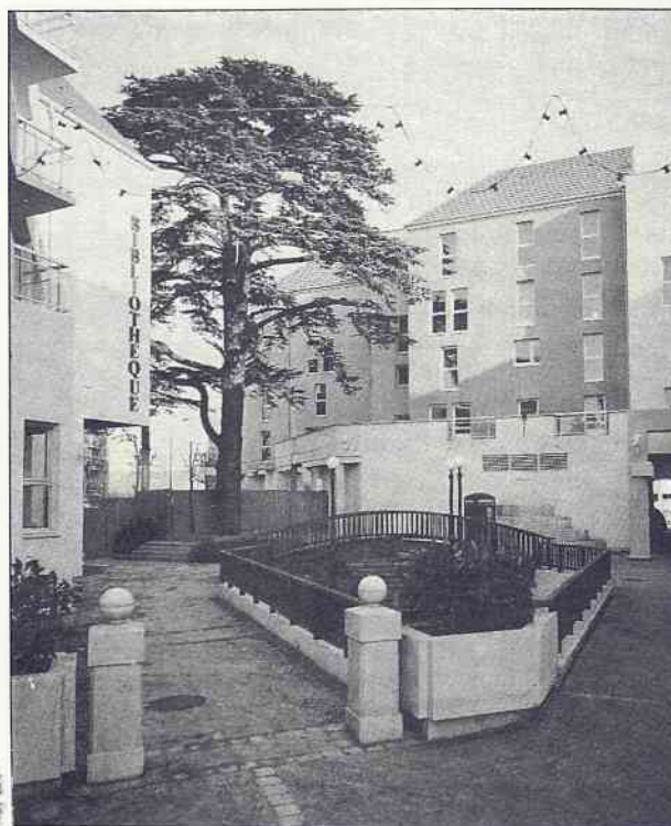
Décembre 1984, la première tranche de travaux s'achève.
