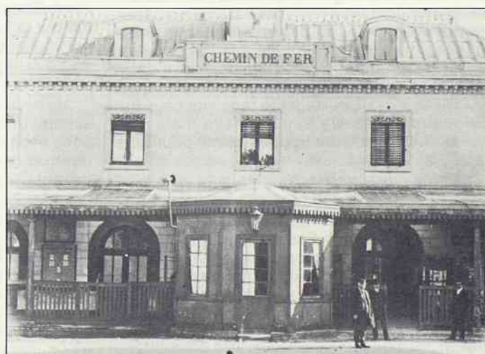
Face à l'église, l'ancienne gare de Sceaux (Coll. part.).
