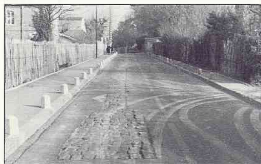
Boulevard Desgranges : réparation provisoire d'une tranchée
