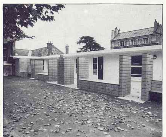
École du Centre, bâtiment rénové : il manque encore la verrière sur les piliers.
