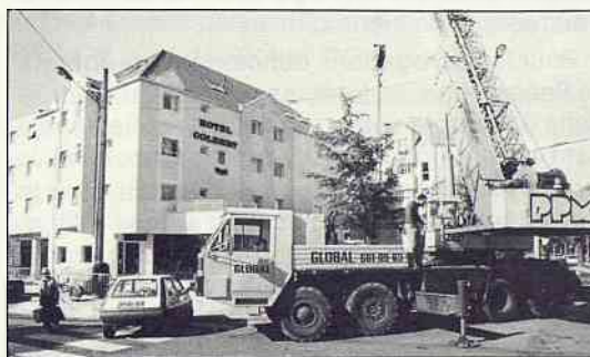
Le camion grue pose l'arbre dans la cuvette construite spécialement à cet effet.
