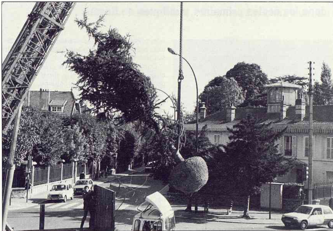
La grue vient de prendre l'arbre sur le camion transporteur.
