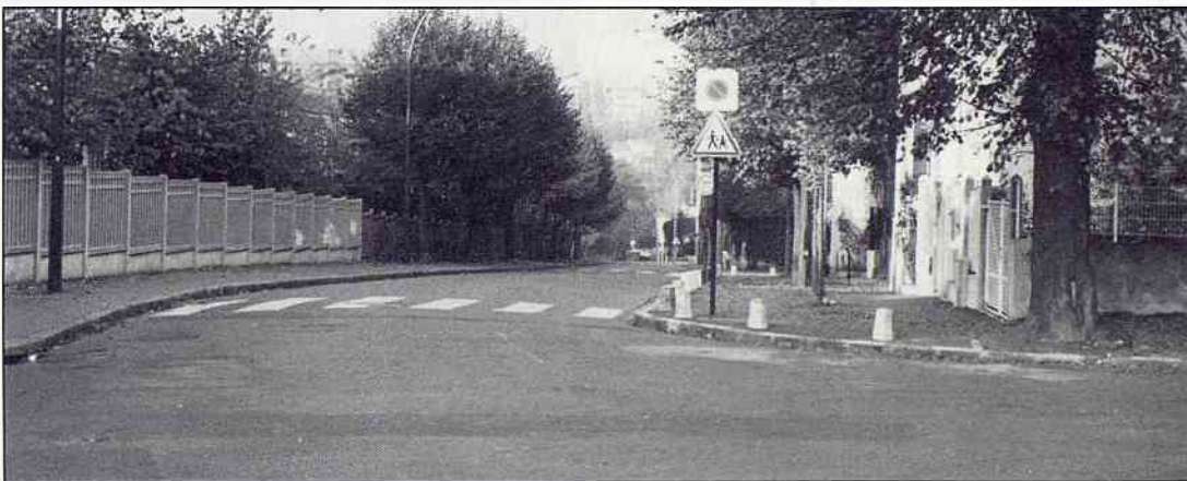
Avenue de la Gare : mise à l'alignement côté est, entre la rue des Clos-Saint-Marcel et la place de la Gare.
