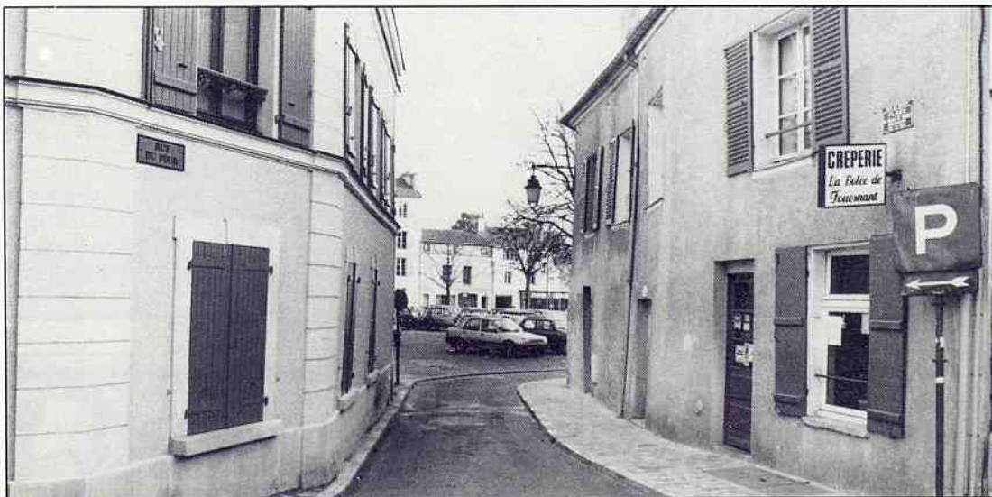
Rue du Four : élargissement du trottoir du côté crêperie, PTT.
