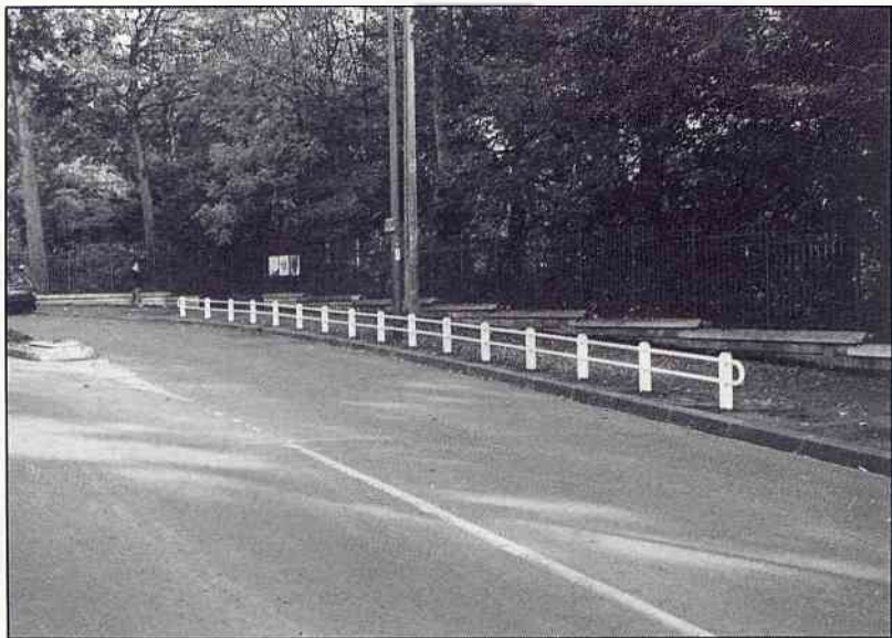
Rue Paul-Couderc : construction d'une grille de protection du trottoir côté est.
