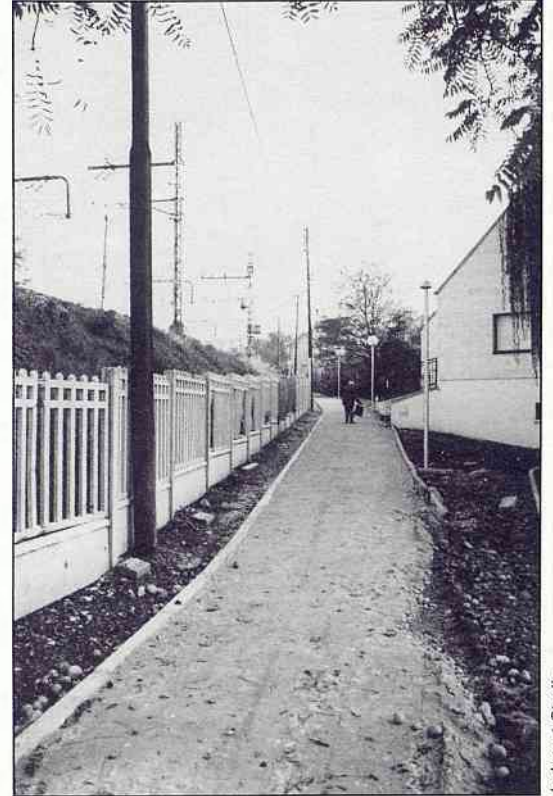
Chemin latéral : réfection du revêtement (en cours).
