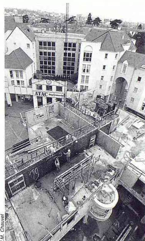
Le chantier de l'îlot 5 Charaire
