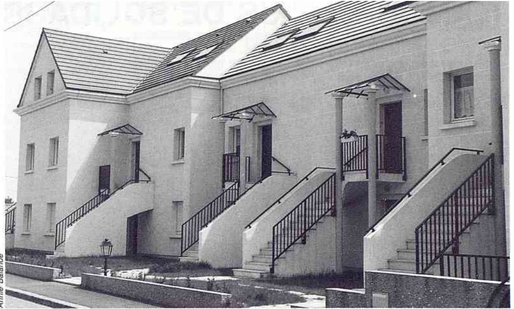
Logements privés situés 23, rue Madeleine-Crenon, terminés courant 1987.
