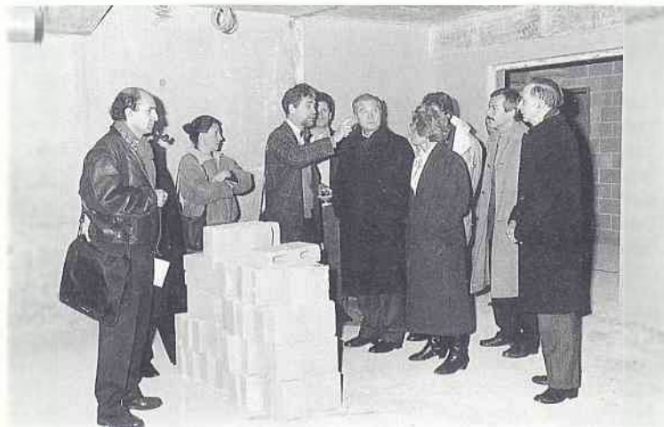
Visite du chantier de l'extension de la MJC : les explications de l'architecte, M. Christian Vilette.
