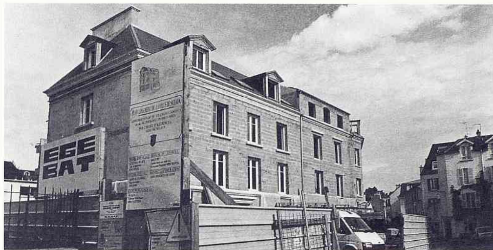
Rue des Imbergères, 26 logements HLM en cours de construction
