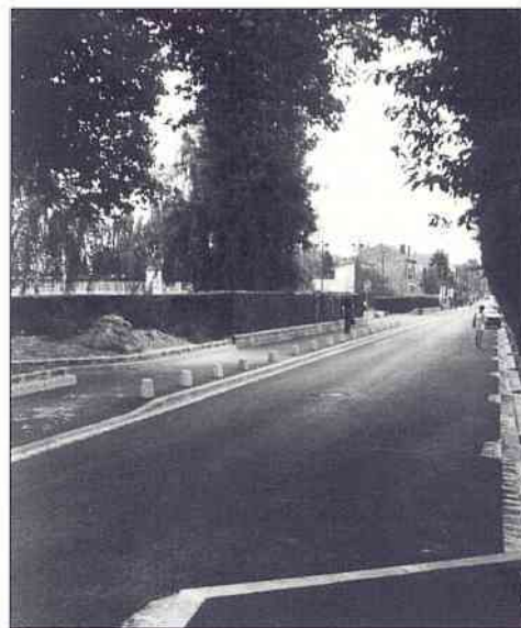
Réfection de la rue de l'Yser.
