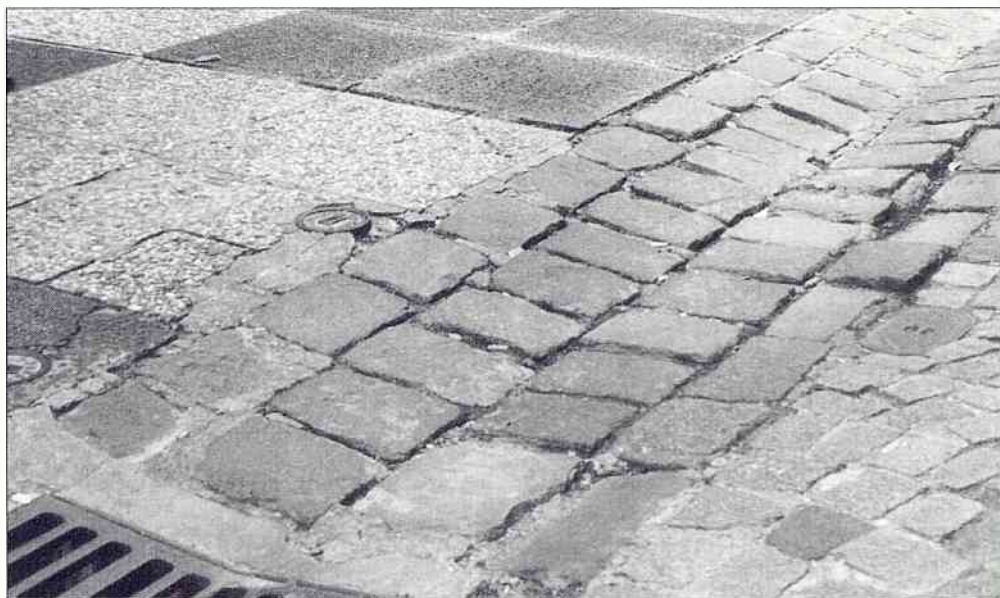
Un revêtement déjà bien altéré.
