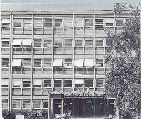
Les bâtiments de la Faculté de Sceaux, créés en 1968
