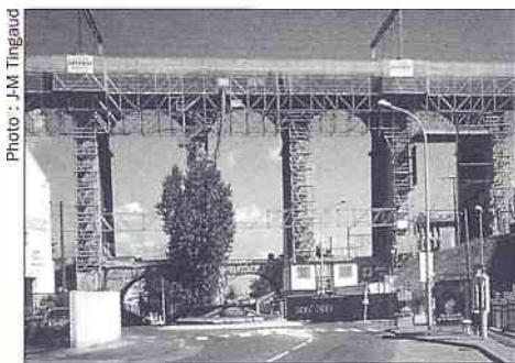
Meudon, viaduc SNCF, 1996. Observatoire photographique du paysage, CAUE 92.
