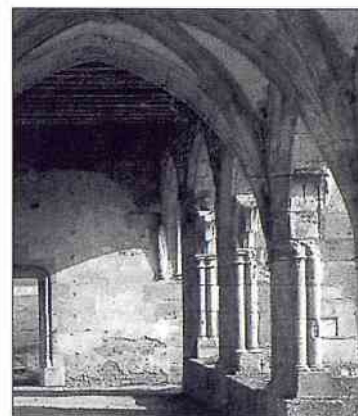
La galerie de l'ancienne bibliothèque de l'abbaye de Cîteaux (XV e siècle).
