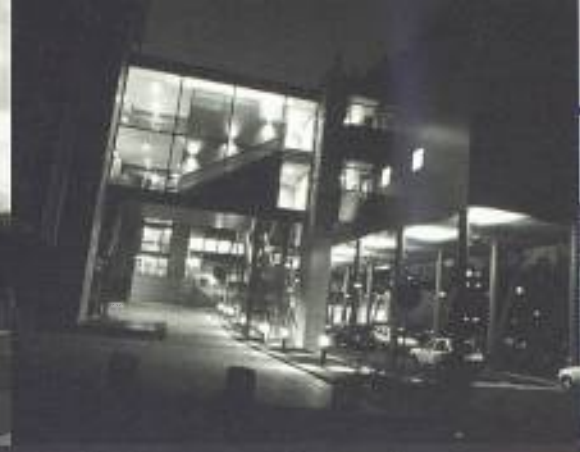
La faculté Jean Monnet. rénovation de Guédot et Chaslin
