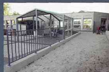
Création d'un accès pour les personnes à mobilité réduite à l'école élémentaire des Blagis.
