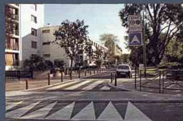
Aménagement en zone 30 de la rue Gaston-Lévy (section nord) : Pour une meilleure sécurité et des trottoirs plus confortables.
