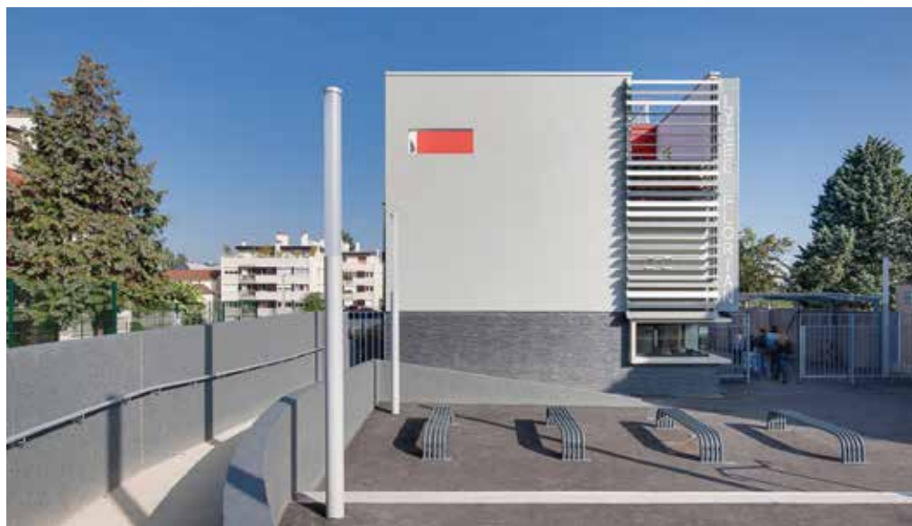
Les travaux de restructuration et d'extension du lycée des métiers Florian devraient être achevés d'ici un an.
