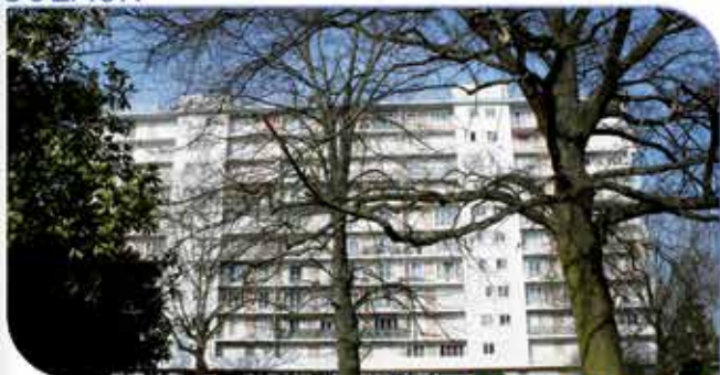
Résidence des Bas Coudrais, 695 logements locatifs sociaux
