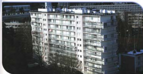
Résidence des Bas-Coudrais, 695 logements locatifs sociaux Travaux de ravalement avec isolation thermique en cours : 30, 32 Avenue Jean Perrin
