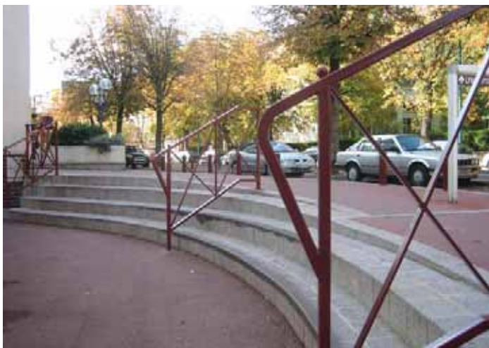
Des rampes installées sur les marches conduisant à la rue Bergeret de Frouville procurent un appui pour les personnes âgées et limitent la pratique parfois dangereuse du skate board constatée à cet endroit.
