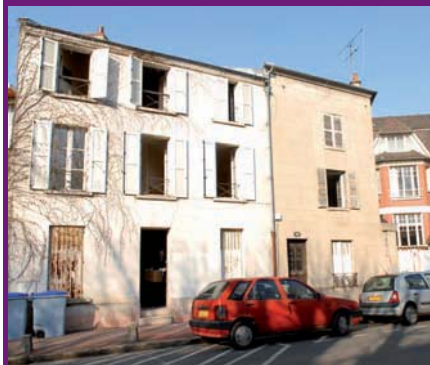
Les bâtiments à démolir aux 36 et 36 bis avenue du président Franklin-Roosevelt.
