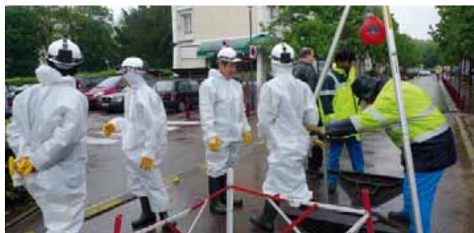
Exemple de travaux d'assainissement rue du Docteur-Roux, en 2008-2009.
