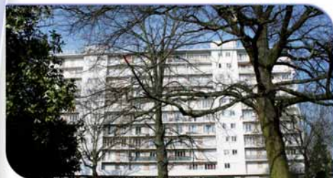
Résidence des Bas Coudrais, 695 logements locatifs sociaux
