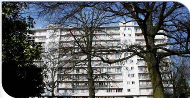
Résidence des Bas Coudrais, 695 logements locatifs sociaux
