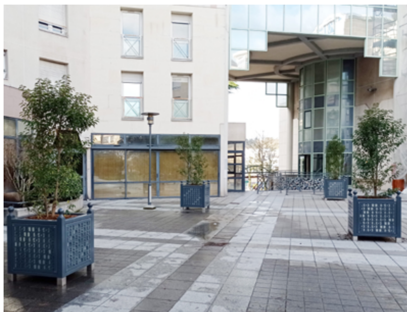
Bacs végétalisés installés square Robinson
